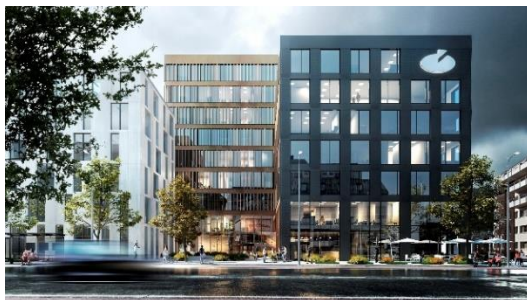
Figur 1 Kontorbygget Holtermanns veg 1-13 i Trondheim er sertifisert som BREEAM «Excellent». Prosjektet oppnår energikarakter A. Energiforsyningsløsning er basert på fjernvarme og fjernkjøling. Se www.byggalliansen.no for mer info.
