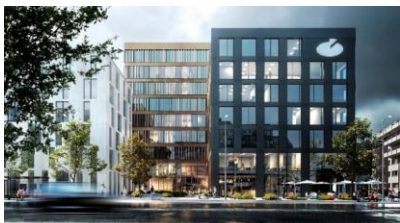
Figur 1 Kontorbygget Holtermanns veg 1-13 i Trondheim er sertifisert som BREEAM «Excellent». Prosjektet oppnår energikarakter A. Energiforsyningsløsning er basert på fjernvarme og fjernkjøling. Se www.byggalliansen.no for mer info.
